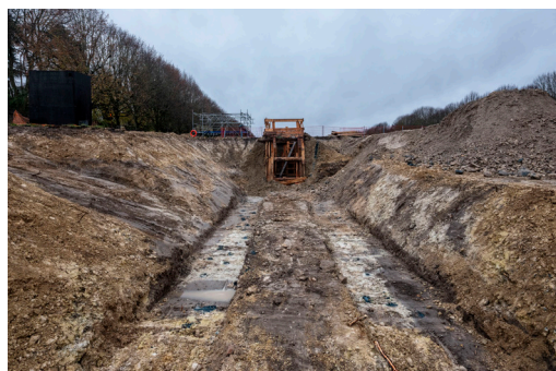
Le chantier de restauration du Grand Canal ©OPPIC - Gilles Coulon
