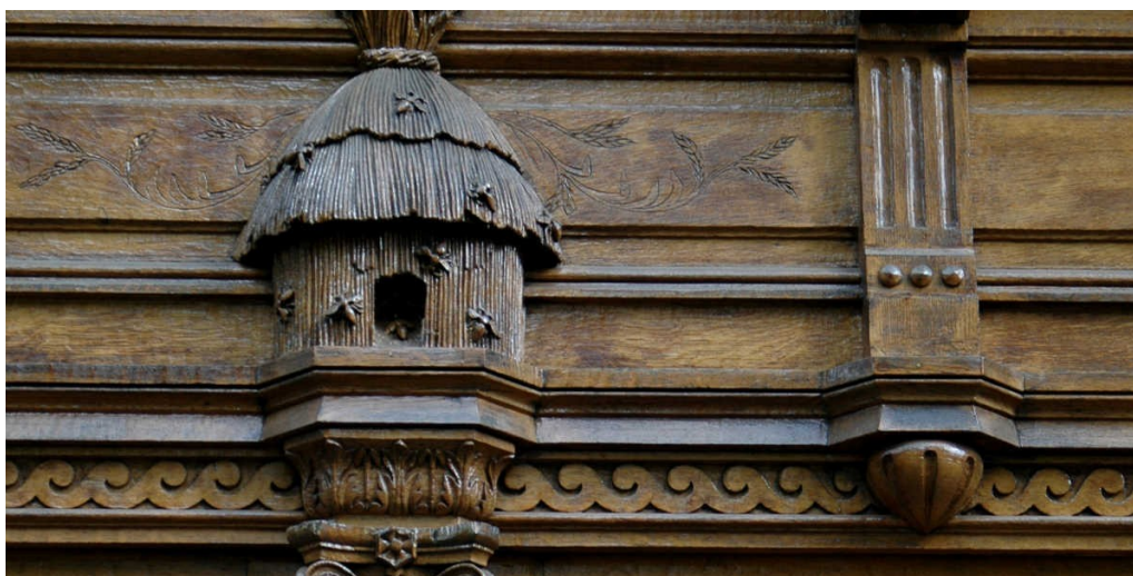
Détail d'une entrée de passage, avenue Ledru-Rollin. Photo Vincent Delaveau.
