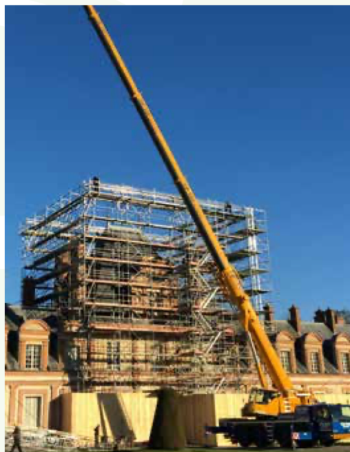
Montage de l'échafaudage pour la restauration des toitures du pavillon central de l'aile des Ministres, septembre 2016.
