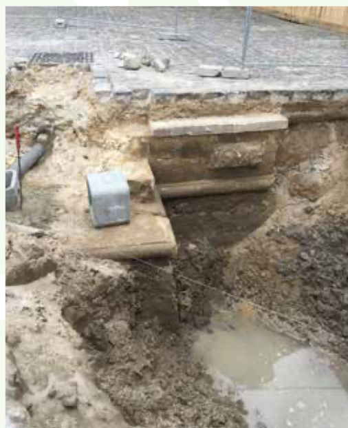
Fig 2. Mise au jour d'une portion de mur d'escalpe des anciens fossés du XVI ème siècle, lors des excavations réalisées dans la cour d'Honneur en mai 2017.
