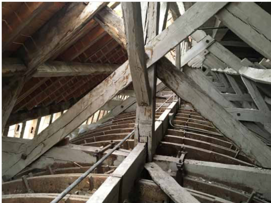
Fig 3. Structure de la voûte de la galerie de Diane dégagée et en cours de nettoyage, dans le cadre des travaux de restauration des couvertures, juin 2017.
