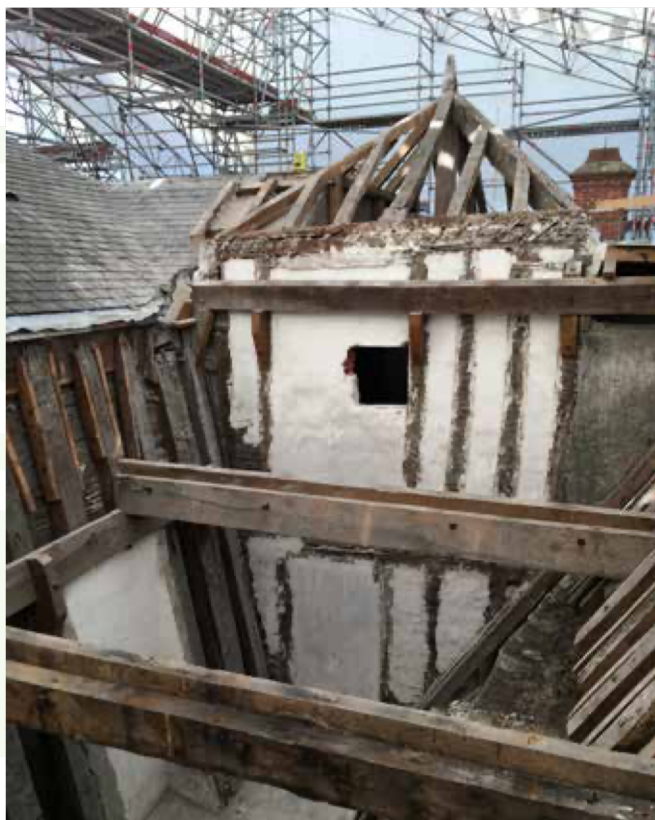
Fig 4. Dégagement des anciens chêneaux dans l'angle Nord-Est du quartier des Princes, mai 2017.
