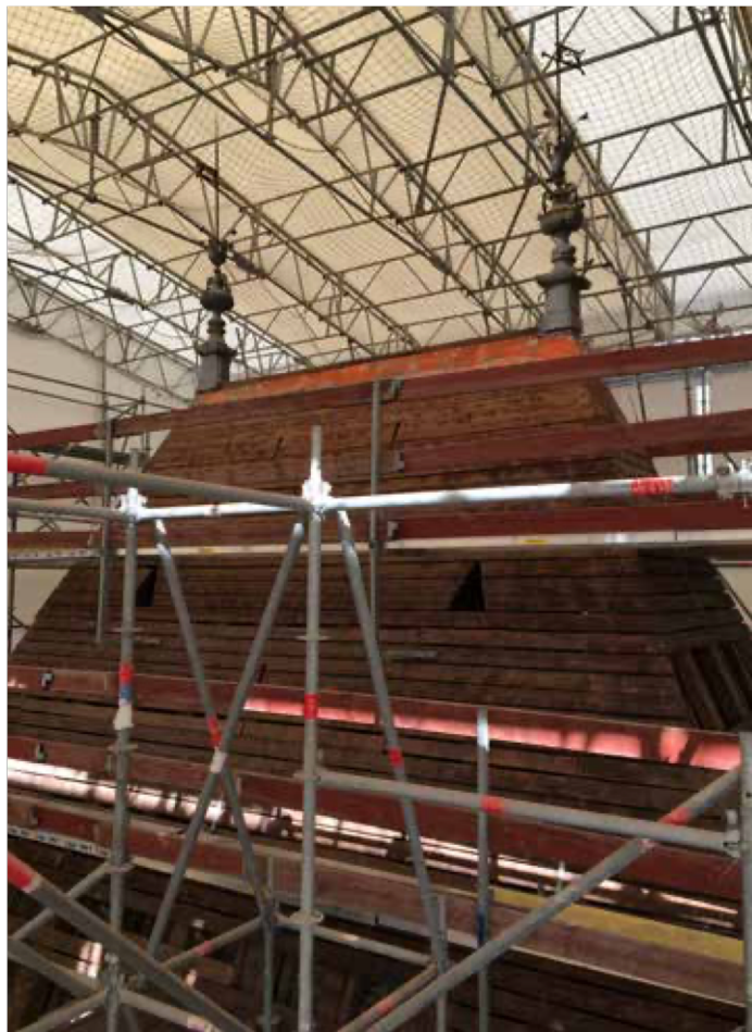
Fig 5. Restauration des couvertures du pavillon central de l'aile des Ministres, avril 2017.
