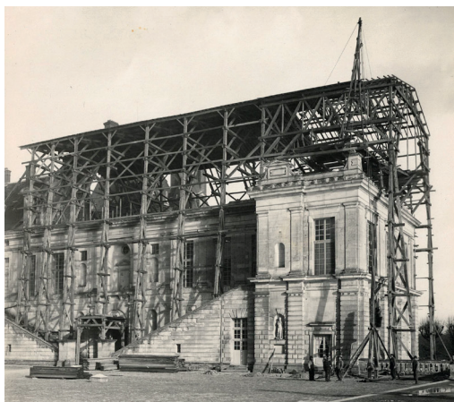
Aile de la Belle Cheminée en cours de restauration.
