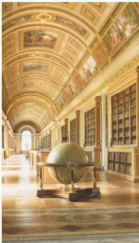
Jean-Maximilien Hurtault. La galerie de Diane . Reconstruction de la voûte et du gros œuvre, 1810-1814. La décoration de la voûte fut exécutée pendant le Restauration. Les bibliothèques furent installées sous Napoléon III.
