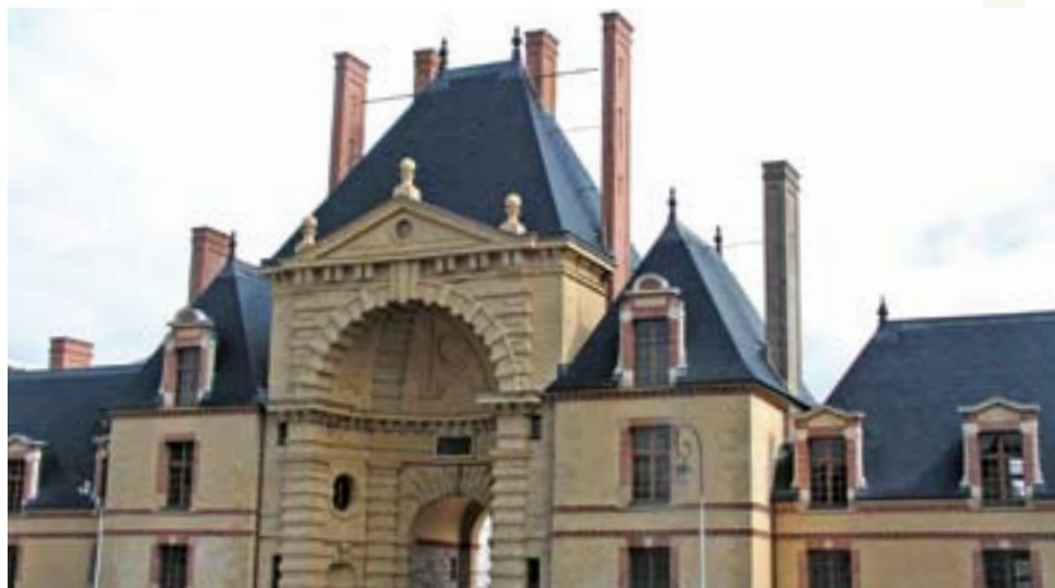
La réhabilitation du Quartier Henri IV prévu pour accueillir l'Ensemble Européen de Musique de Chambre « Pro Quartet » a commencé par l'aile occidentale et le Grand Portail
